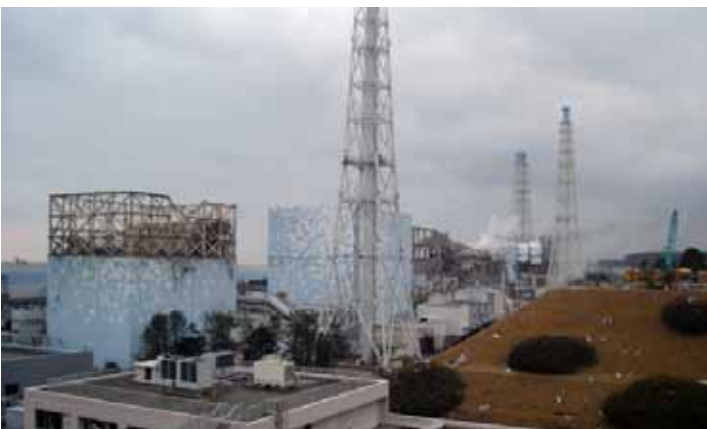
写真：福島第一原発1～4号機 2011年3月16日公開 東京電力ホールディングス
